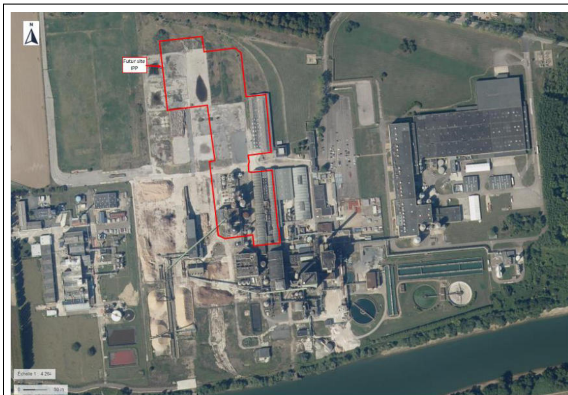
Figure 8 : Vue aérienne Géoportail de 2019
